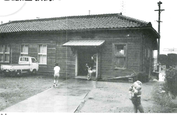
飾磨港駅 明治28年に飾磨駅として開業、大正4年に飾磨港駅となる。同駅は主に港からの貨物輸送のために開設され、大正期から高度経済成長期の物流を支えていた。しかしモータリゼーションの波に押され、昭和61年に廃止された。〈飾磨区玉地・昭和56年・提供＝呉田武司氏〉
