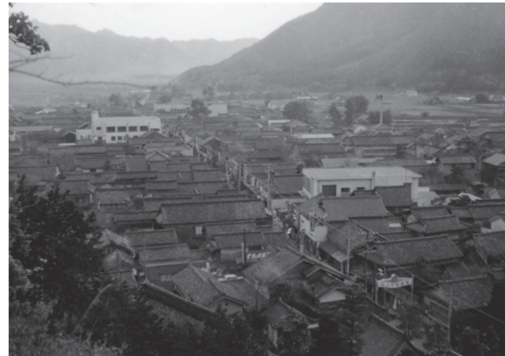
◀甲賀山から見た成松の町 中央を貫く通りは旧但馬街道の筋に形成された商店街で、この頃「成松センター街」と呼ばれていた。手前の白い建物は成松農協。通りの奥には氷上町役場の姿も見える。〈丹波市(旧氷上町)・昭和38年〉
